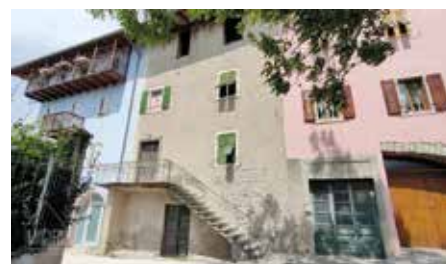
LASINO casa terra cielo da ristrutturare completamente, in piazza dell'abitato, piano terra cantine 60 mq e garage 25 mq, tre piani abitativi da 60 mq, con possibilità di balcone. Euro 69.000
