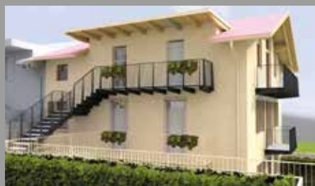
VEZZANO casa in fase di nuova ristrutturazione con 4 appartamenti acquistabili separatamente, terreno 3.000 mq, giardini, garage, posti auto, finiture a scelta! Info in ufficio
